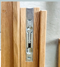
targette haute et basse sur vantail semi fixe
